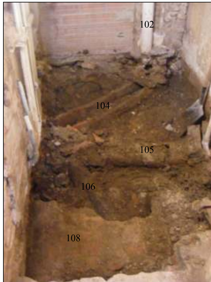
Fig. 13.- Vista general de la xarxa de clavegueram de la finca en aquest sector.
