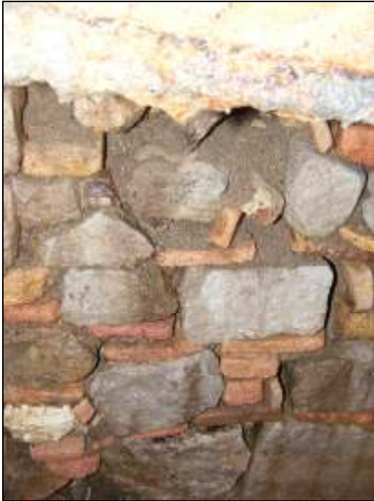
Fig. 19.- Vista del mur meridional del Pou mort.
